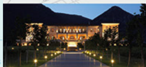
Οινοποιείο Κτήμα Βιβλία Χώρα, Κοκκινόχωρι Καβάλας
