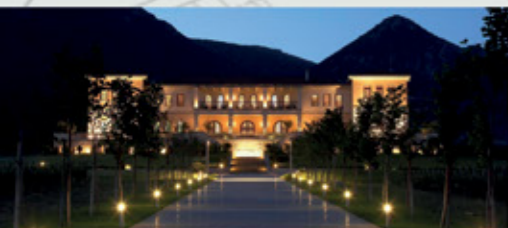
Οινοποιείο Κτήμα Βιβλία Χώρα, Κοκκινόχωρι Καβάλας
