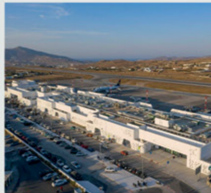
Αεροδρόμιο Μυκόνου (JMK), Μύκονος
